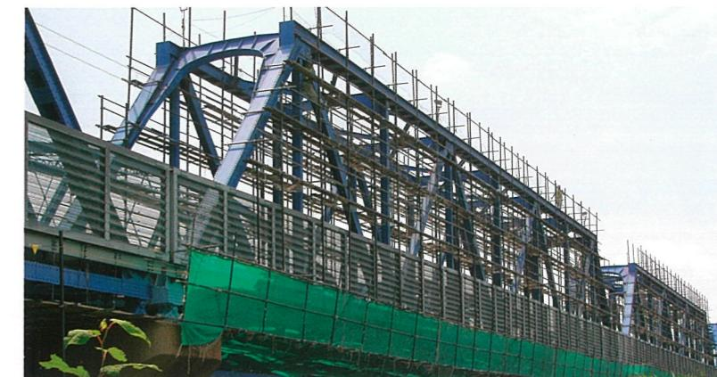
鉄道の橋梁の営業線近接工事(電化区間)では、基本的にUEXCのFRP足場材が使用されています。
